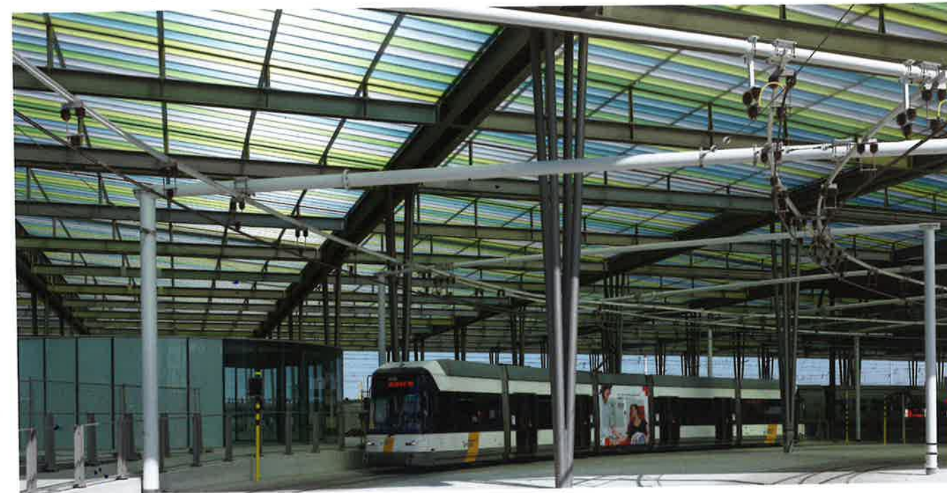
La toiture est constituée de panneaux en polycarbonates translucides posés sur une structure en acier.
